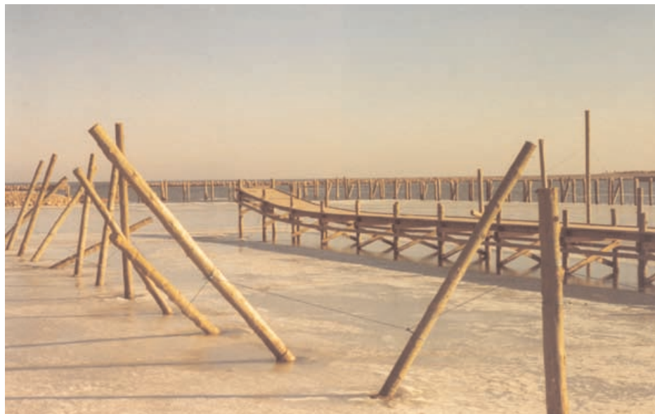
Isvinteren 1980-81 var hård ved den nye havn. Isen skruede pælene op, så flere af broerne lignede den kinesiske mur. Men efter at der blev installeret et afisningsanlæg, som holdt pælene isfrie ved hjælp af luftboller, klarede broerne selv de hårdeste is-angreb.
