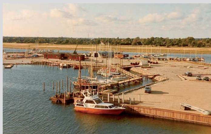
Monteringskajen er klar, og bagest kan man lige skimte de to skurvogne, der udgjorde det for klubhus.
