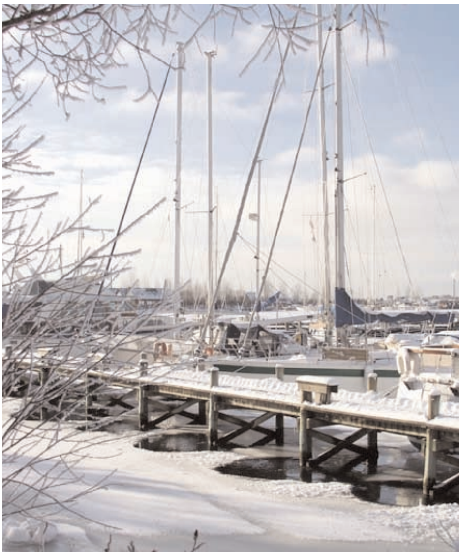
Isvinteren 1980-81 var hård ved den nye havn. Isen skruede pælene op, så flere af broerne lignede den kinesiske mur. Men efter at der blev installeret et afisningsanlæg, som holdt pælene isfrie ved hjælp af luftboller, klarede broerne selv de hårdeste is-angreb.
