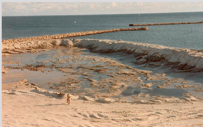
Det sydlige bassin mod stenmolen under uddybning. En sandmole holder vandet ude.
