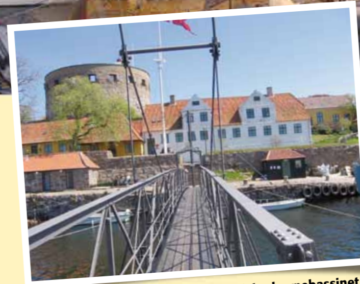
Svingbroen forbinder de to øer og deler havnebassinet i to. Man anløber øerne fra syd.
